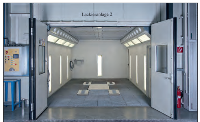
Sonderanlage mit Hebebühne und Luftausblasdüsen
