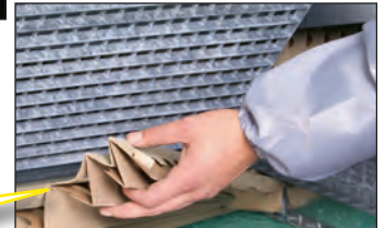
Schneller Filterwechsel
