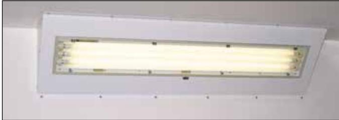
Lampe encastrable en biais pour montage en coin
