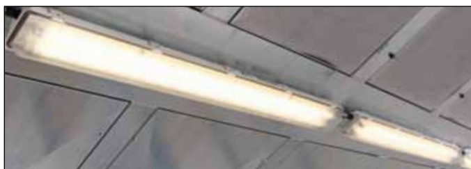
Пластиковый подвесной светильник для взрывоопасной зоны класса 2 и 22
