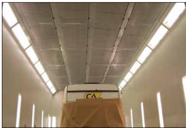
Потолочные притокораспределительные фильтр-элементы
