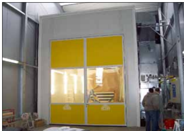
Окрасочно-сушильная кабина с теплорегулятором
